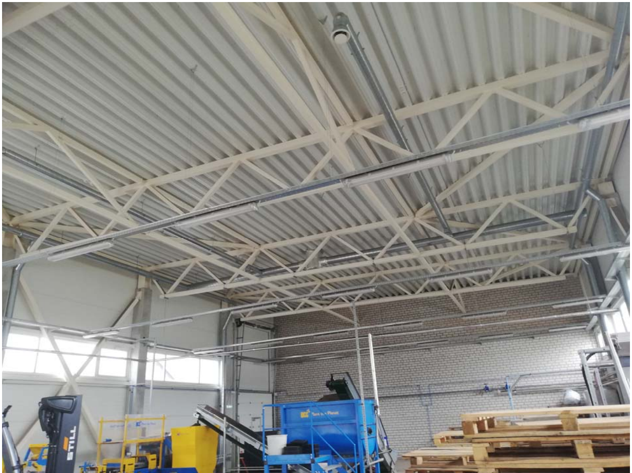
06 pav. Nagrinėjamo statinio stogo konstrukcijų fotografacija
