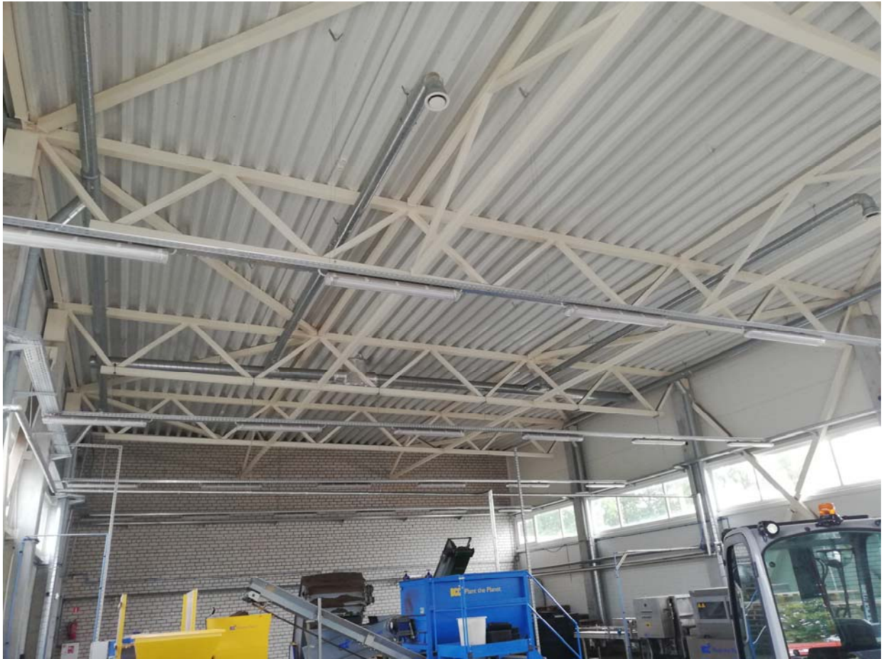
05 pav. Nagrinėjamo statinio stogo konstrukcijų fotografacija
